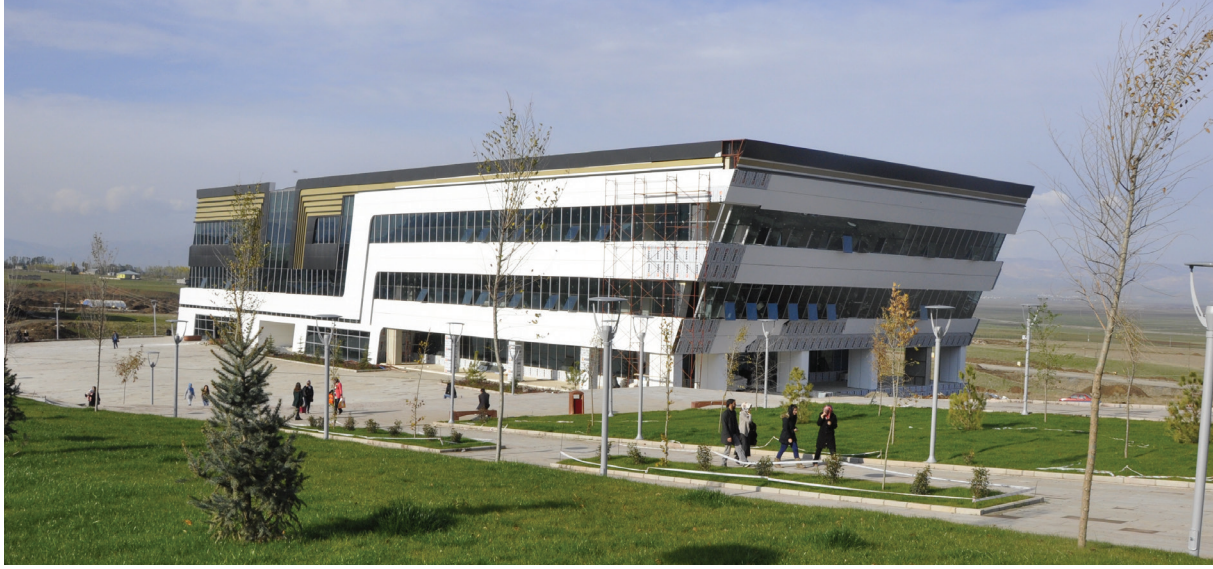
Resim 8. Yapımı Devam Eden Kütüphane ve Bilgi İşlem Merkezi
