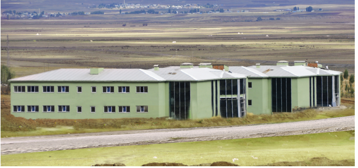
Resim 9. Yapımı Devam Eden Merkezi Araştırma Laboratuvarı Binası
